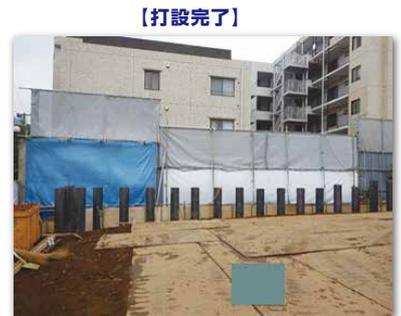
マンション建設工事に於ける外構L型擁壁を計画されるなか、建物基礎とL型擁壁底盤との干渉が課題でありましたが、YOSAKU工法(自立式擁壁)の採用により建物基礎との干渉が解消となりました。また、自立式擁壁とした事により余分な残土処理等、発生しない部分も高く評価頂きました。元請様には養生鉄板の敷設等ご協力いただき、安全且つ工期内に工事を完了することが出来ました。☆ご採用いただき、誠に有り難うございました。
