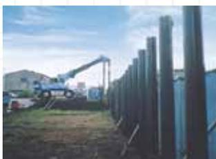
① 鋼管杭を横方向・柱列的に打設貫入していきます。
