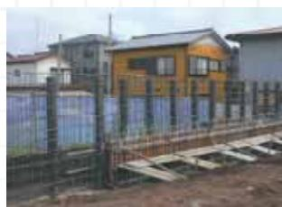
③ 型枠をし、コンクリートを充填します。
