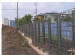
② 基礎部分(壁面最下部)を構築し、壁面部分の鉄筋を配筋します。
