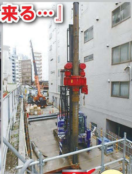
杭の種類  $\phi 355.6 \text{ mm}$   $Dw750 \text{ mm}$   $L=25.70\text{m}$  28set  $\phi 355.6 \text{ mm}$   $Dw750 \text{ mm}$   $L=27.15\text{m}$  11set
